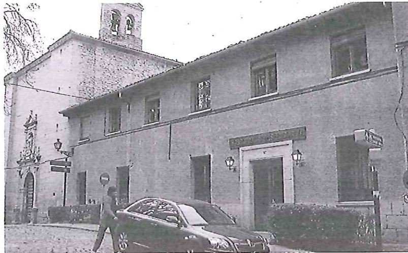
Fachada del Hospital Nuestra Señora de la Misericordia, en la calle Doctor Velasco. :: ANTONIO DE TORRE
