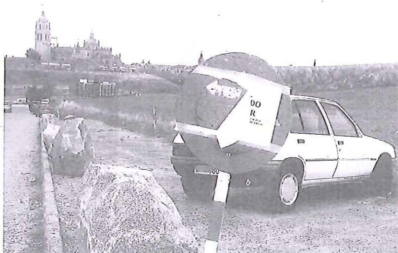
Aspecto que presentaba ayer los exteriores del recinto hospitalario. :: ANTONIO DE TORRE
